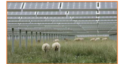
Granja solar de generación
